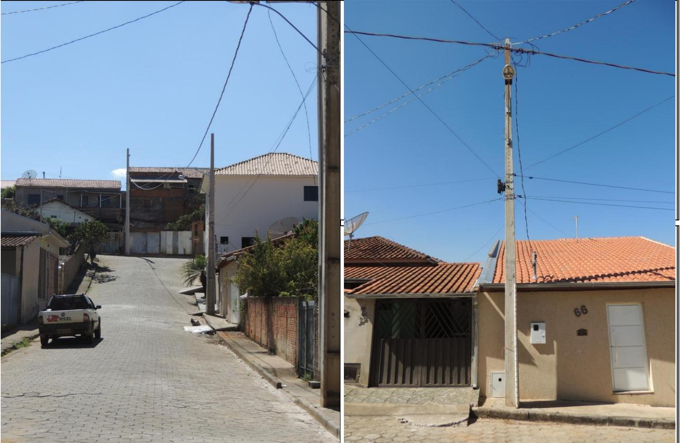
**Serviços Executados:** Instalado 01 poste circular 11-300 equipado e 01 conjunto de luminária de LED 100w completo / Substituído 01 poste 10-300 DT para 01 poste 11-300 DT equipado / Lançado 02 vãos de cabo de BT
